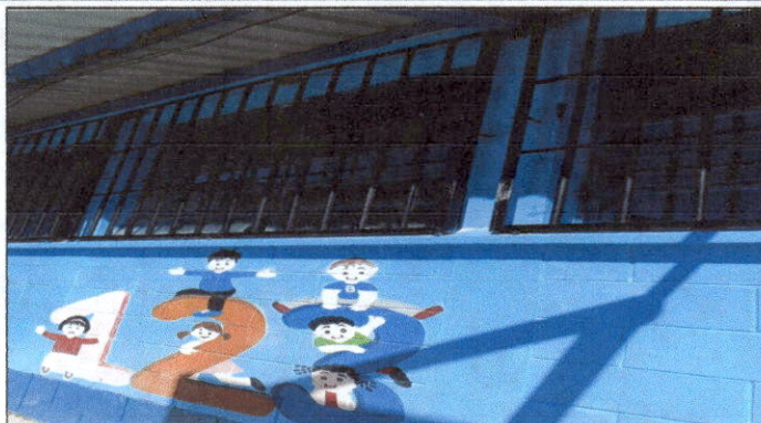
Foto 2: Sustitución de vidrios en ventanas y sustitución de balcones de metal
