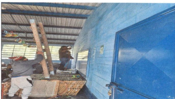
Foto 4: Pintando en muros exteriores e interiores
