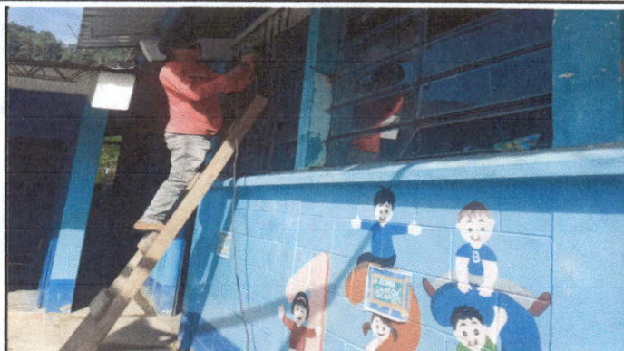
Foto 2: Cambiando vidrios quebrados. Colocando balcones de metal
