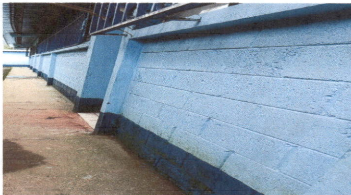
Foto 4: Pintura en muros exteriores e interiores
