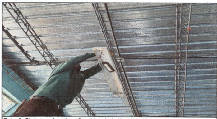
Foto 5: Sistema electrico: Cambiando la Iluminación.
