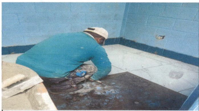
Foto 3: Sustituyendo Piso de aula en mal estado de 5 aulas
