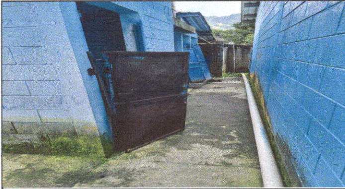
Foto 1: Mantenimiento a estructura (lijado, cambio de tubo, cepillado sujeción, aplicación de pintura puertas de baños)
