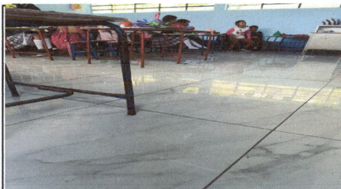
Foto 3: Sustitucion de piso en 5 aulas
